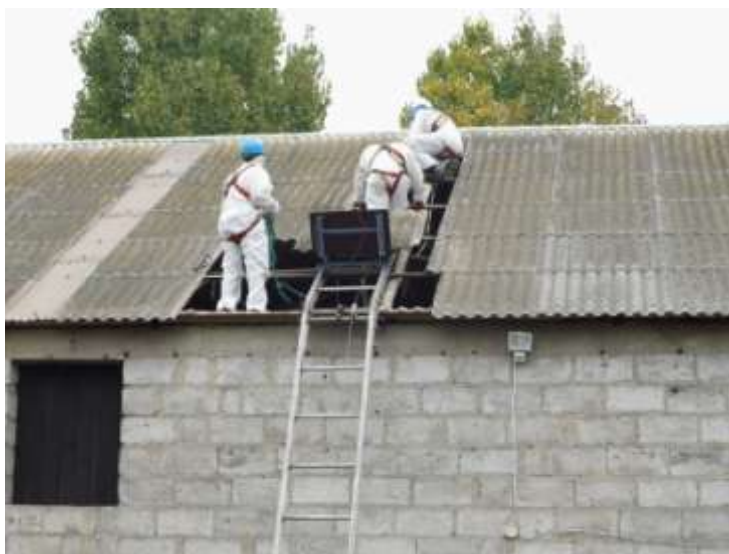
Fot. 9 Demontaż płyt eternitowych z budynku gospodarczego.
