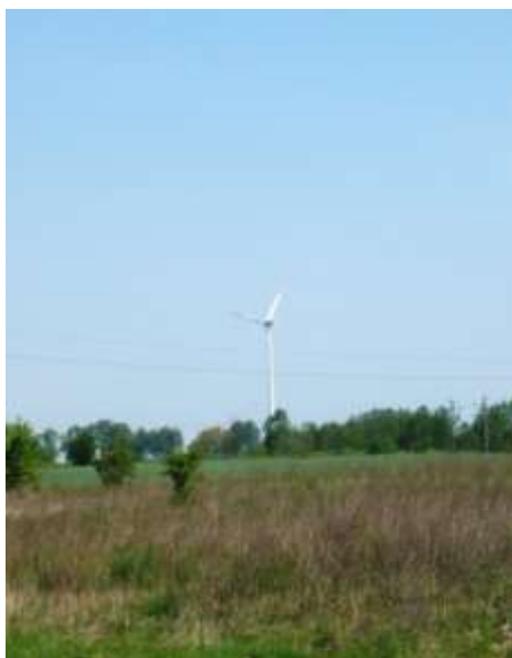
Fot. 7. Elektrownia wiatrowa w Pasiece. (Źródło: Starostwo Powiatowe w Gnieźnie, opracowanie własne)
