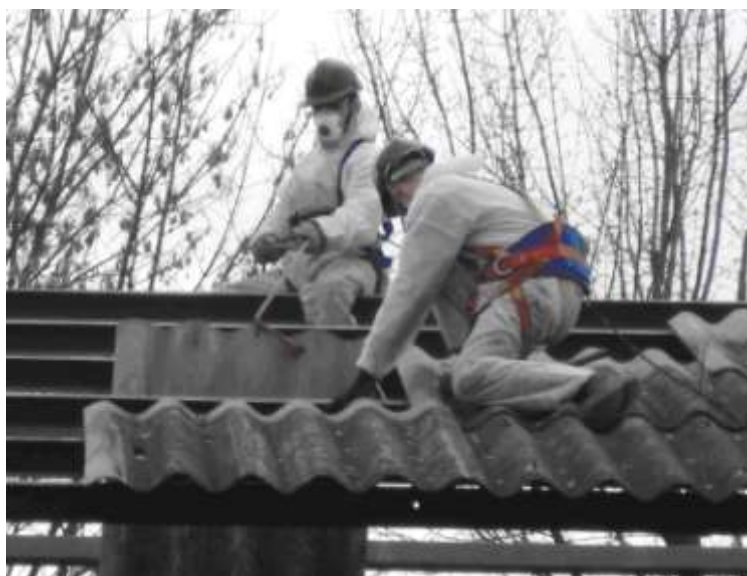
Fot. 10. Demontaż płyt eternitowych z budynku mieszkalnego.
