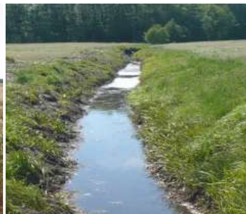
Fot. 4. Rów po konserwacji
