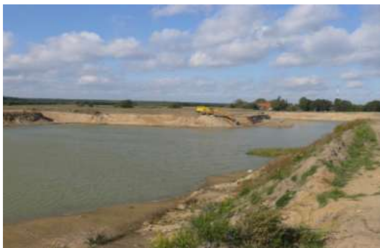
Fot. 5. Eksploatacja kruszywa naturalnego metodą odkrywkową z dwóch poziomów eksploatacyjnych: suchego i zawodnionego, pracująca koparka podsiębierna, z piętra roboczego, którym jest strop złoża, urabia kruszywo z poziomu suchego.
