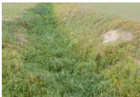
Fot. 1. Rów wymagający konserwacji.
